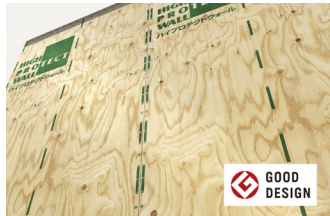
独自開発の高耐衝撃 「ハイプロテクトウォール」を外壁に標準採用。
